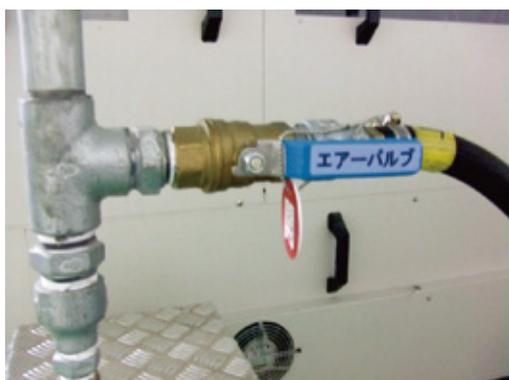
エアバルブ開（設備稼働時）
